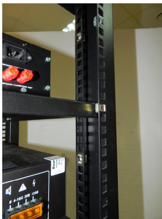
С боковой внутренней стороны стойки с двух сторон закрепляются 4 кронштейна- 2 слева и 2 справа.
