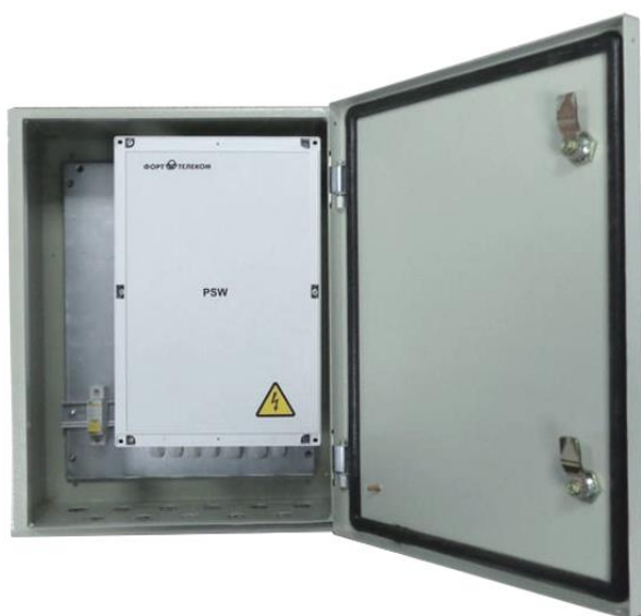
Рисунок 7.3 - Монтаж коммутатора в уличном шкафу.
