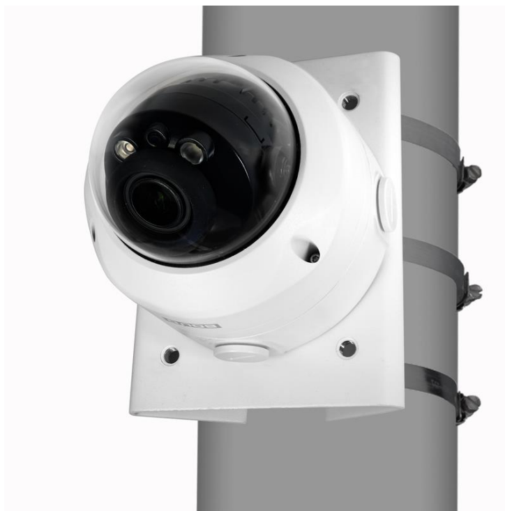
Рисунок 5.11 – Монтаж видеокамеры и монтажной коробки BR-202 на столбовом кронштейне BR-103
